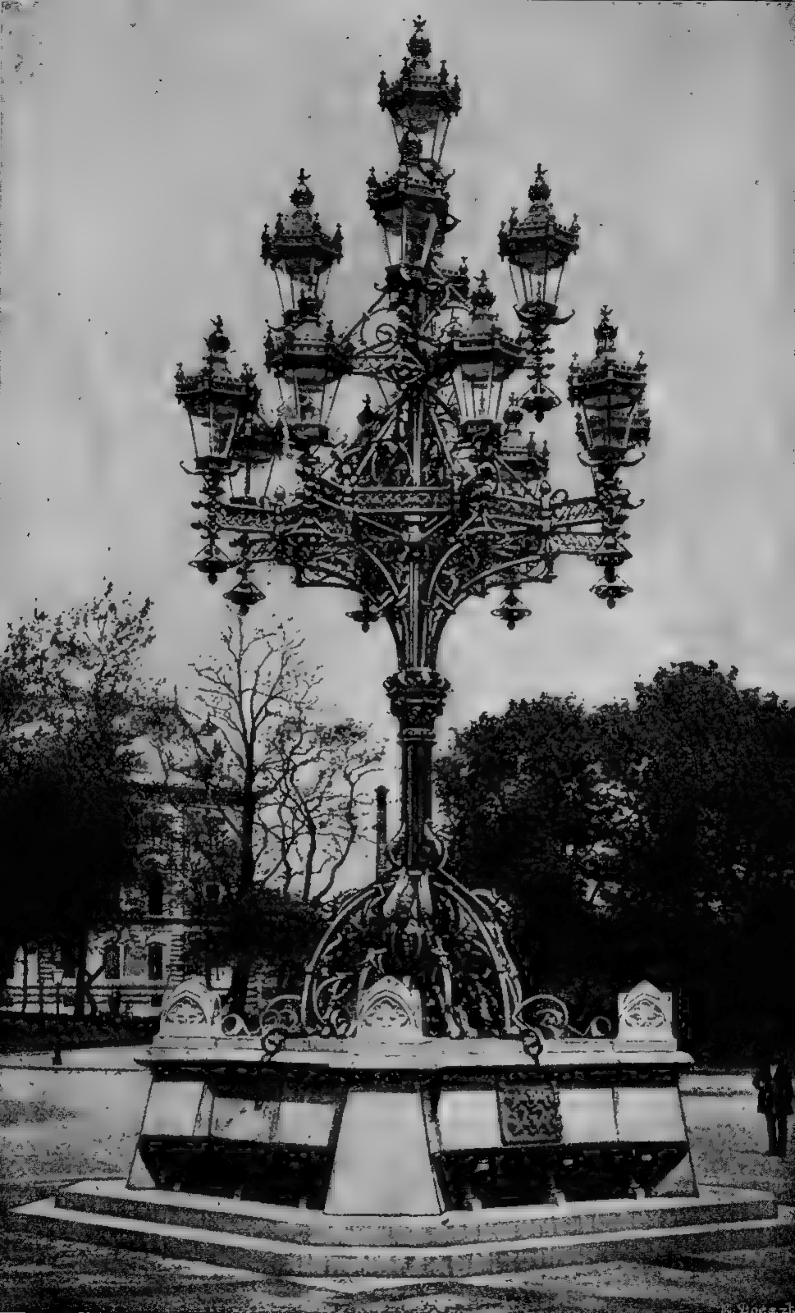
488. Кованый канделябръ о 30 газовыхъ горѣлкахъ на Гольстенской площади въ Гамбургѣ. Исполненъ въ 1882 г. по проекту инж. Андреаса Мейера.
